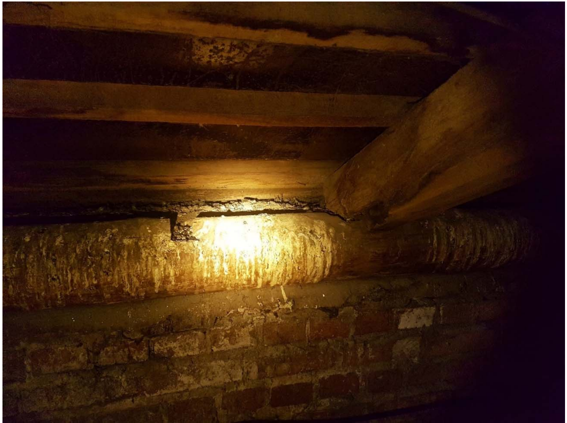
Замачивание стропила и обрешетки крыши
