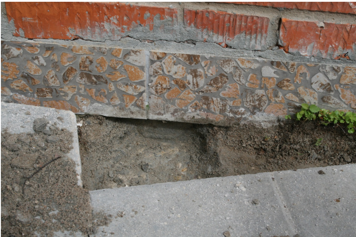
Фото 16. Вскрытие плиточного покрытия стилобата
