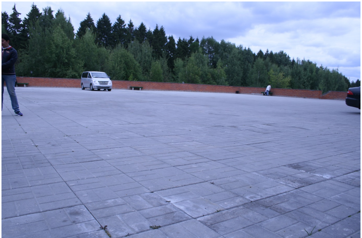
Фото 1. Общий вид покрытия стадиона
