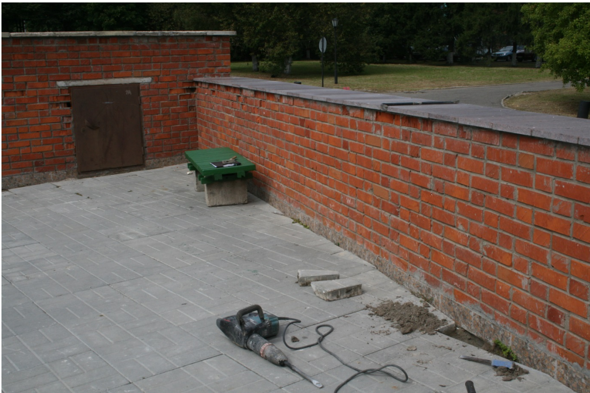
Фото 15. Вскрытие плиточного покрытия стилобата
